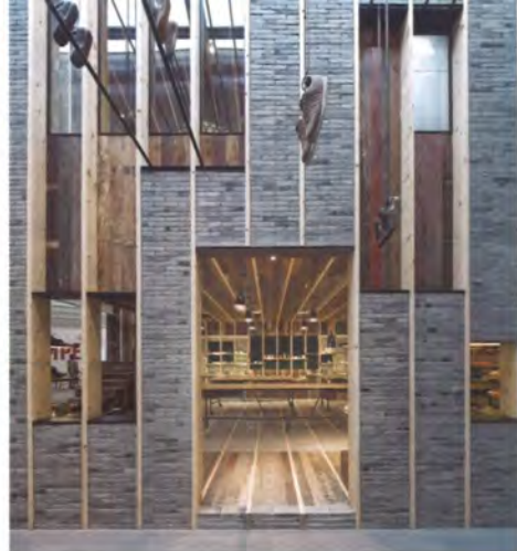
Le showroom Camper ouvert en 2013 à Shanghai rappelle l'ambiance d'une ruelle typique de la ville.
